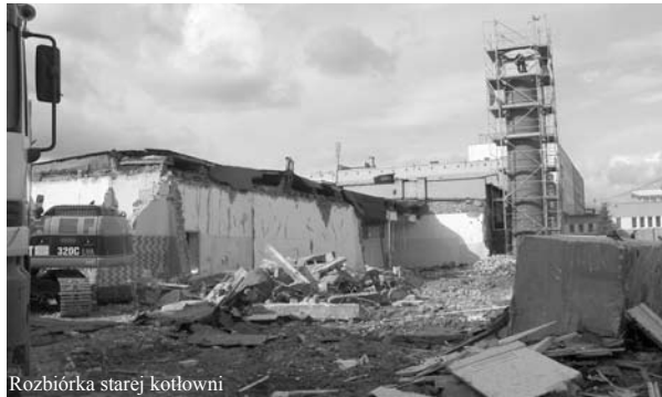
Rozbiórka starej kotłowni
